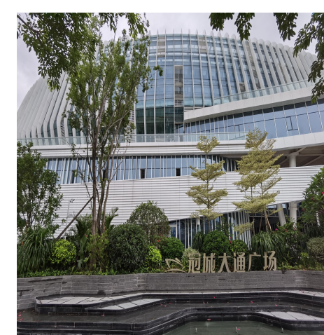
施工后期照片 4
