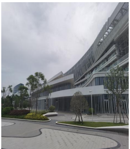
施工后期照片 1
