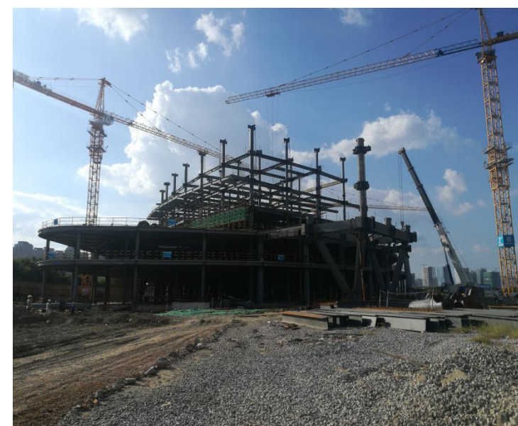
主体工程区监测位点 4
