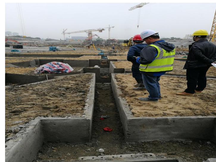
主体工程区监测位点 2
