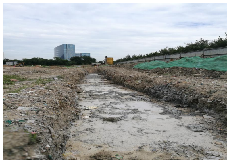
主体工程区监测位点 1
