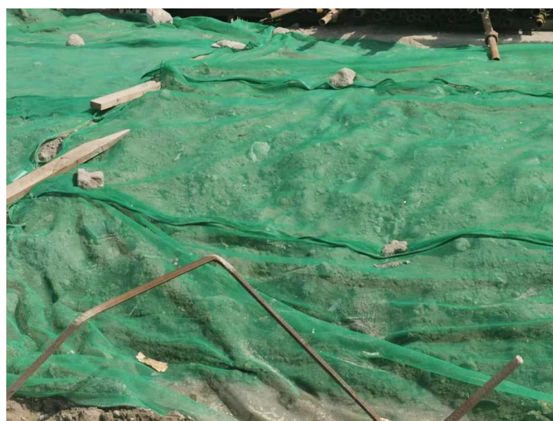
主体工程区监测位点 3
