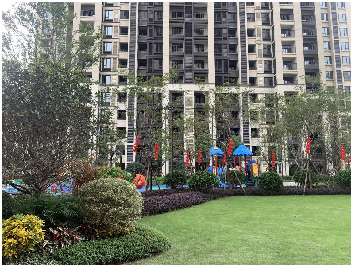
工程验收照片
