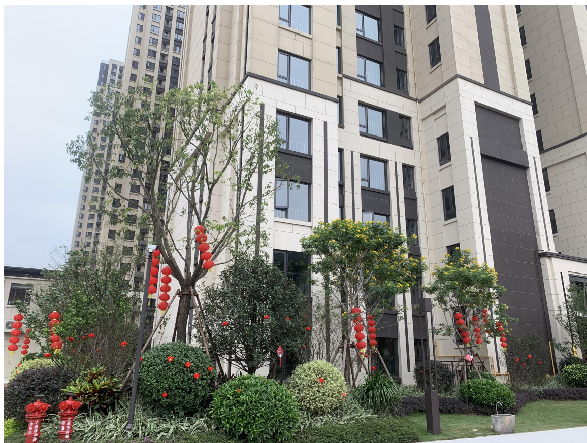
工程验收照片
