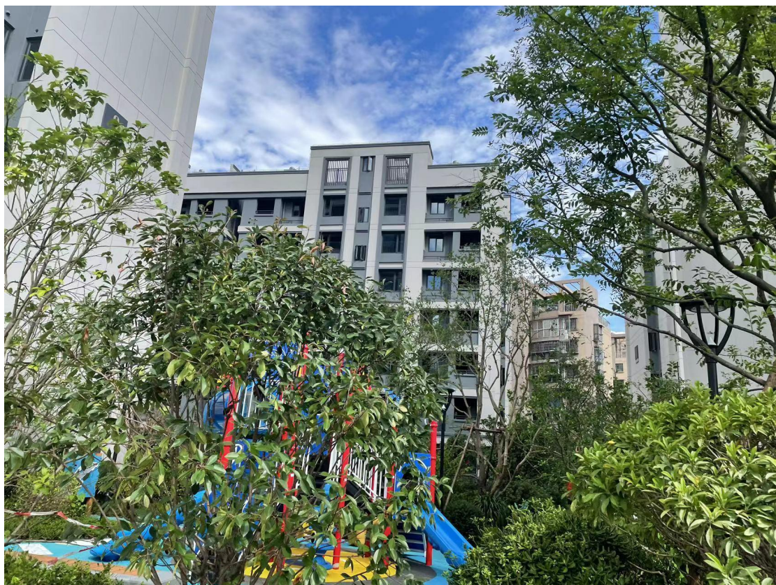
主体工程完工情况
