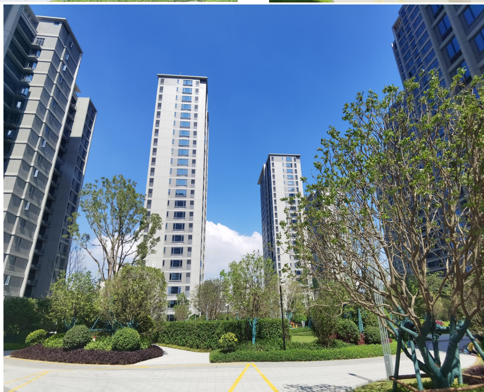
项目主体建成情况
