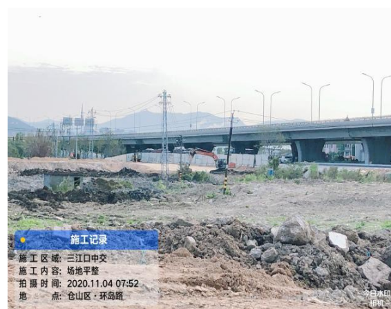
施工前期场地开挖
