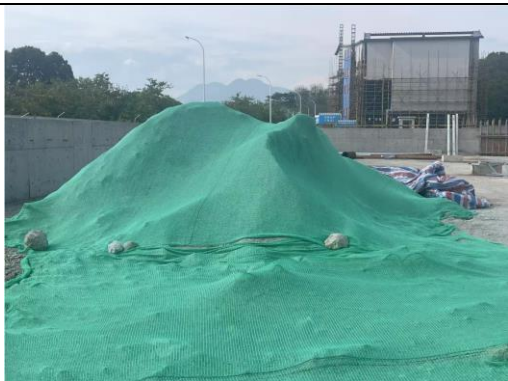
密目网苫盖（施工期）
