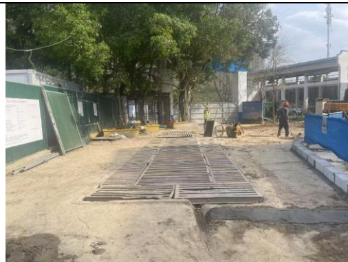
洗车池（施工期）
